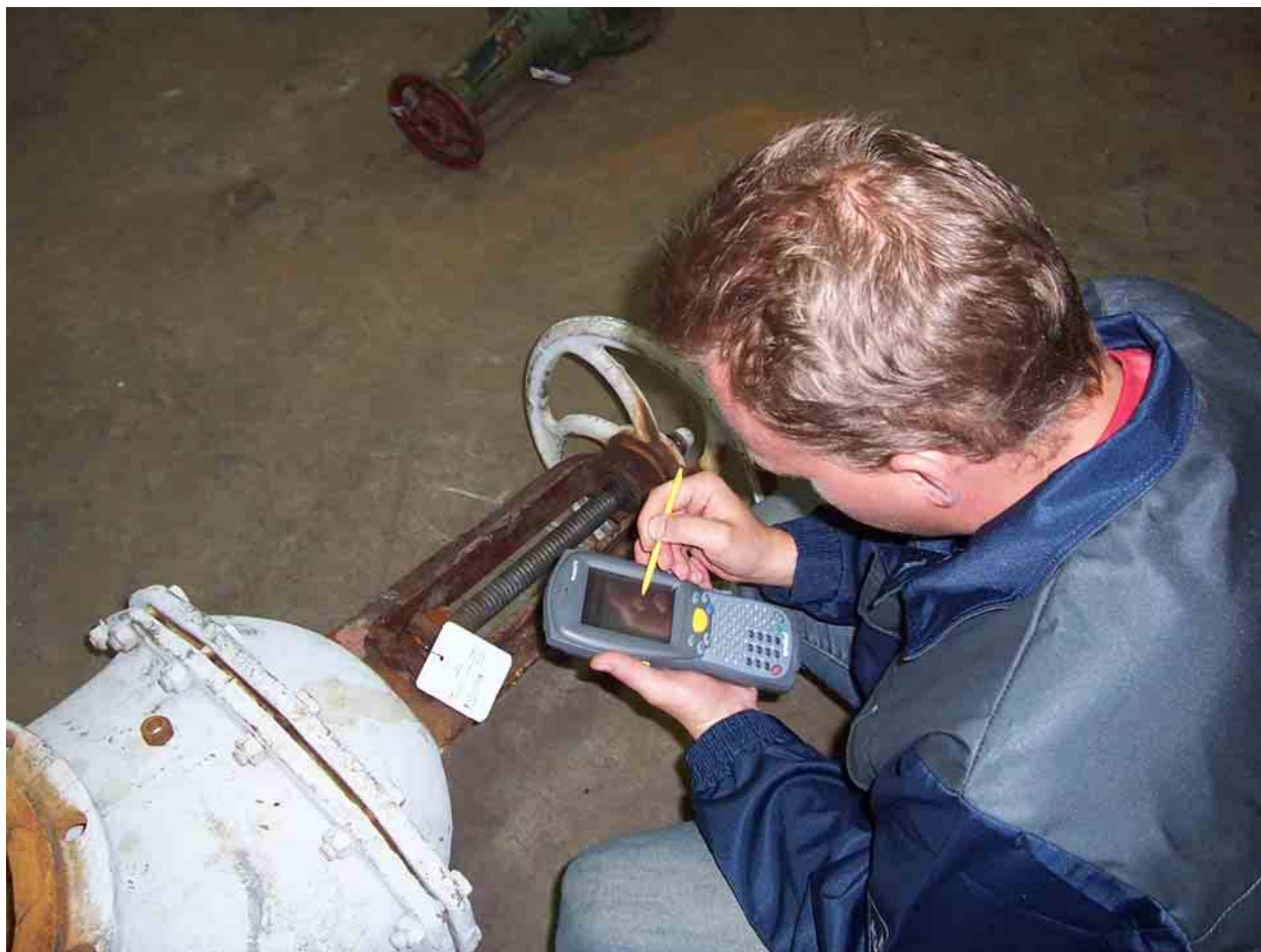
Рис. 2. Приемка запорной арматуры с использованием мобильного АРМ
